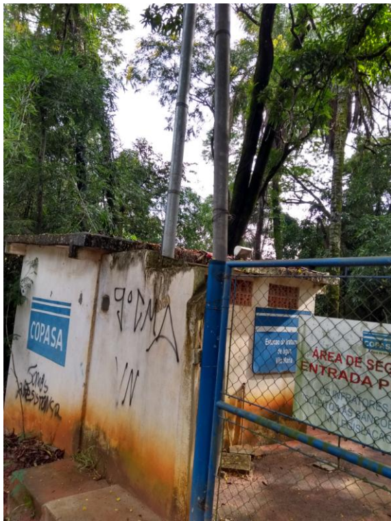
Foto 3: Angico inclinado sobre a área construída
