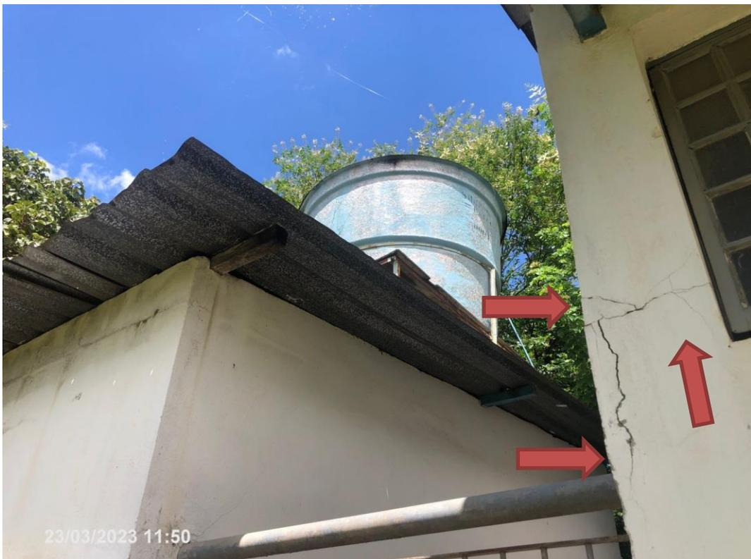
Detalhe de trincas em alvenaria no galpão 04
