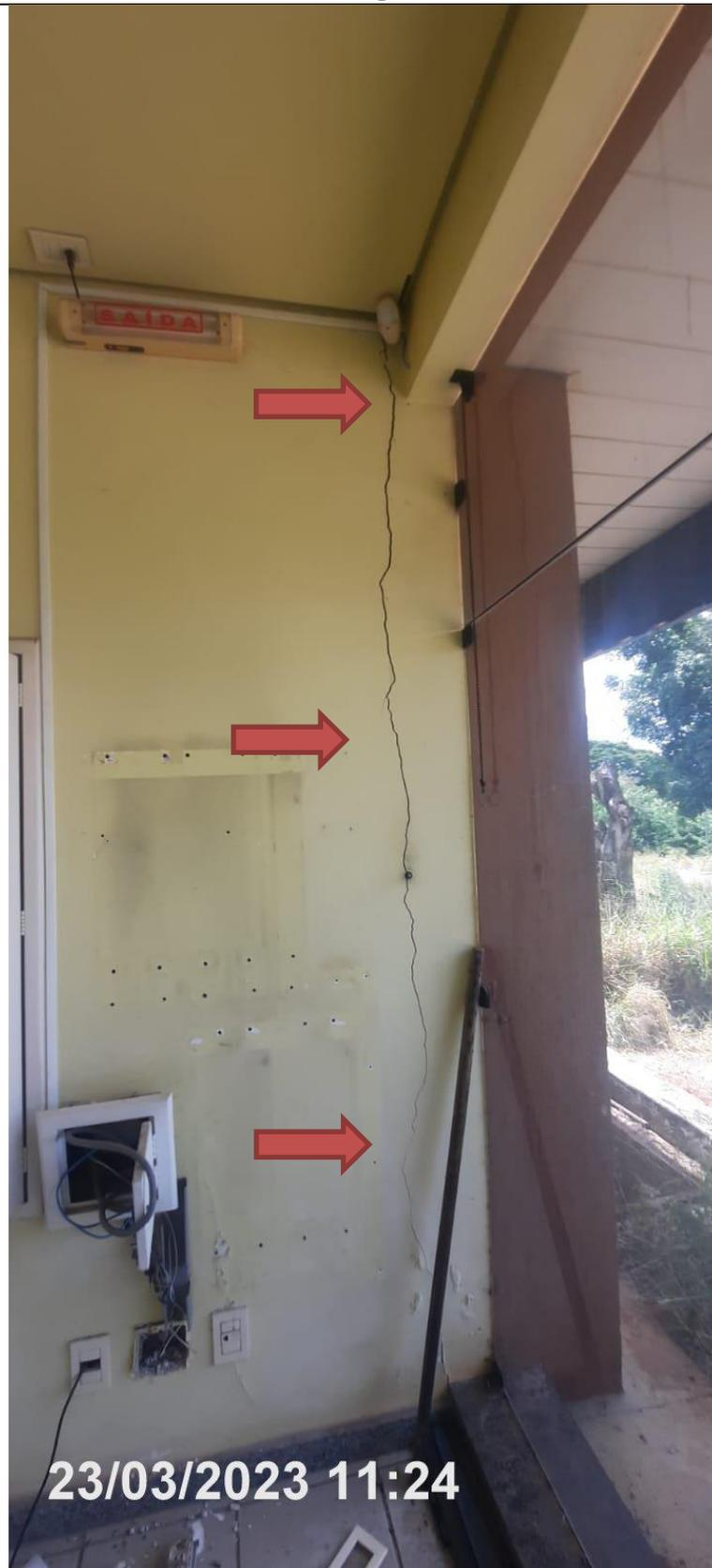
Detalhe da trinca encontrada na parede do corredor lateral
