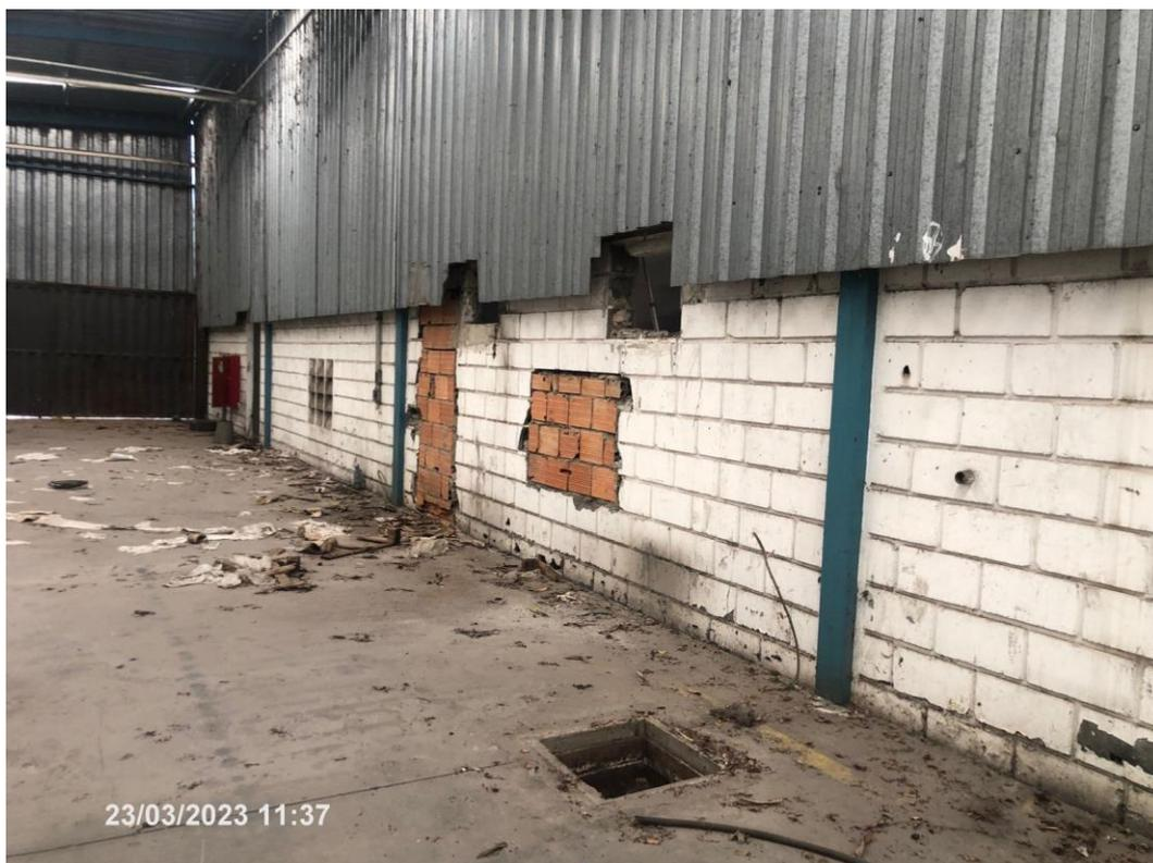
Detalhes de reparos feitos na alvenaria do galpão 03 , caixas de passagem abertas, Hidrante
