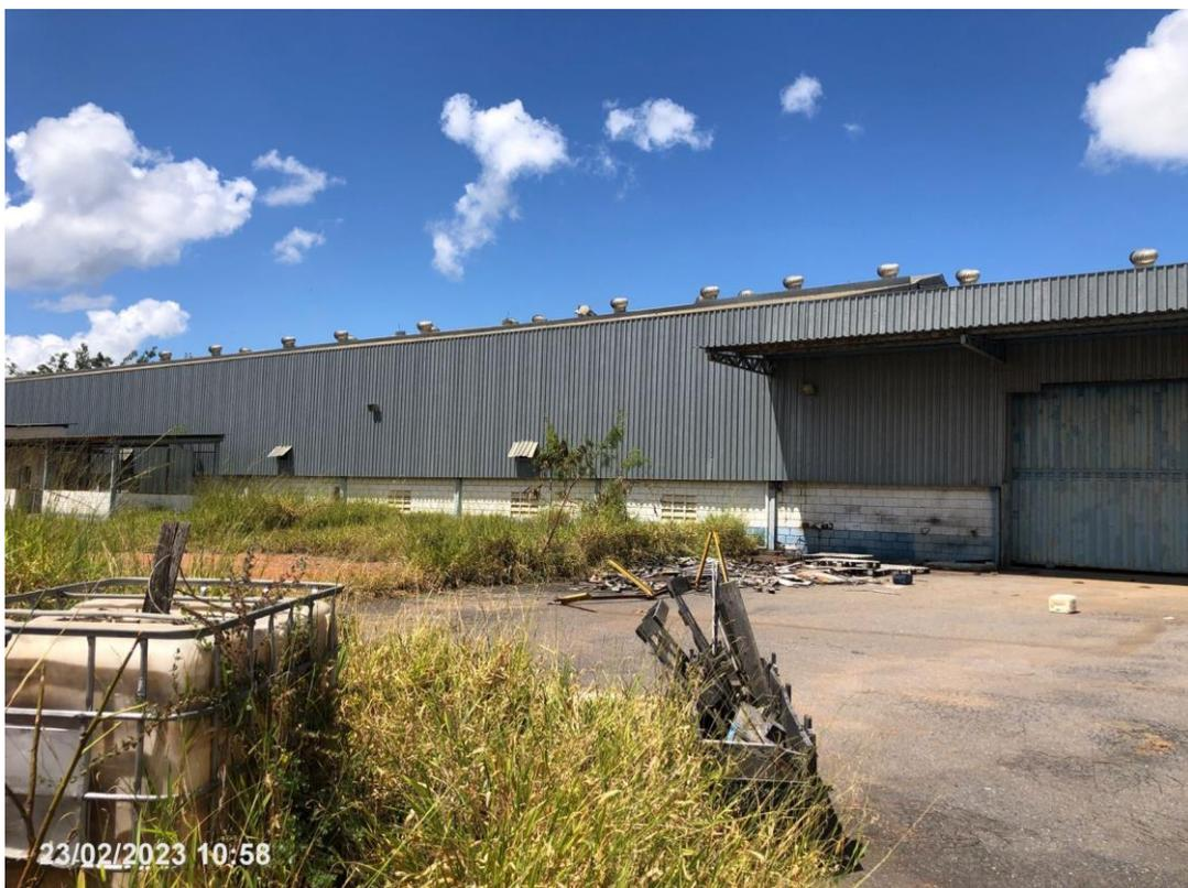
Detalhe do portão de acesso, fechamento lateral e ventilação mecânica do galpão 02
