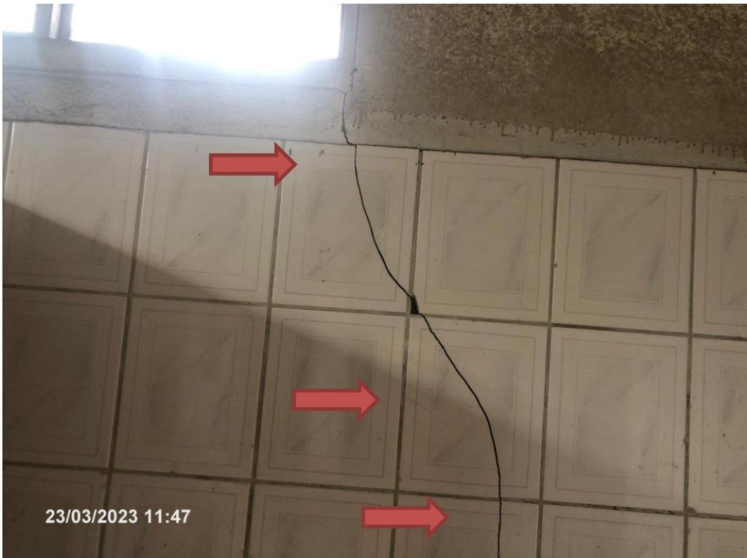
Detalhe trinca na cozinha do refeitório do galpão 04
