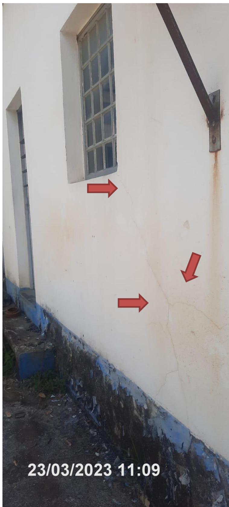
Detectadas trincas nas paredes do anexo do galpão 02
