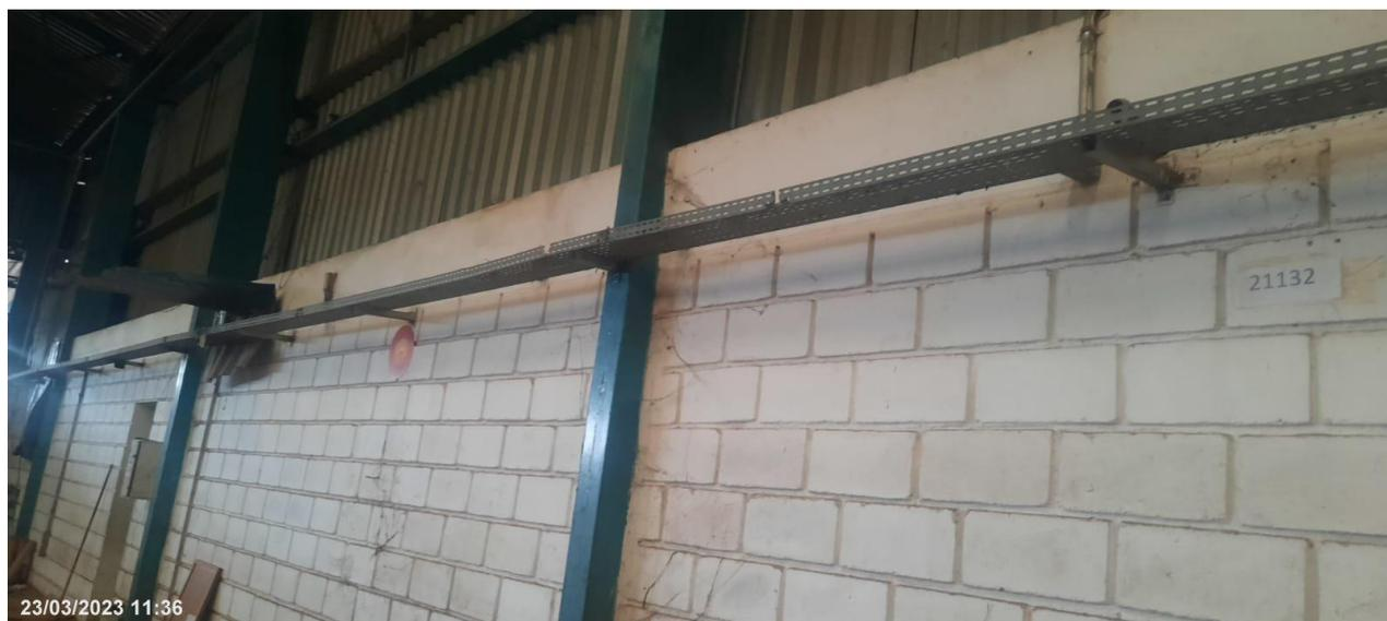
Galpão 02 detalhe da bandeja de alimentação elétrica, estrutura e vedação
