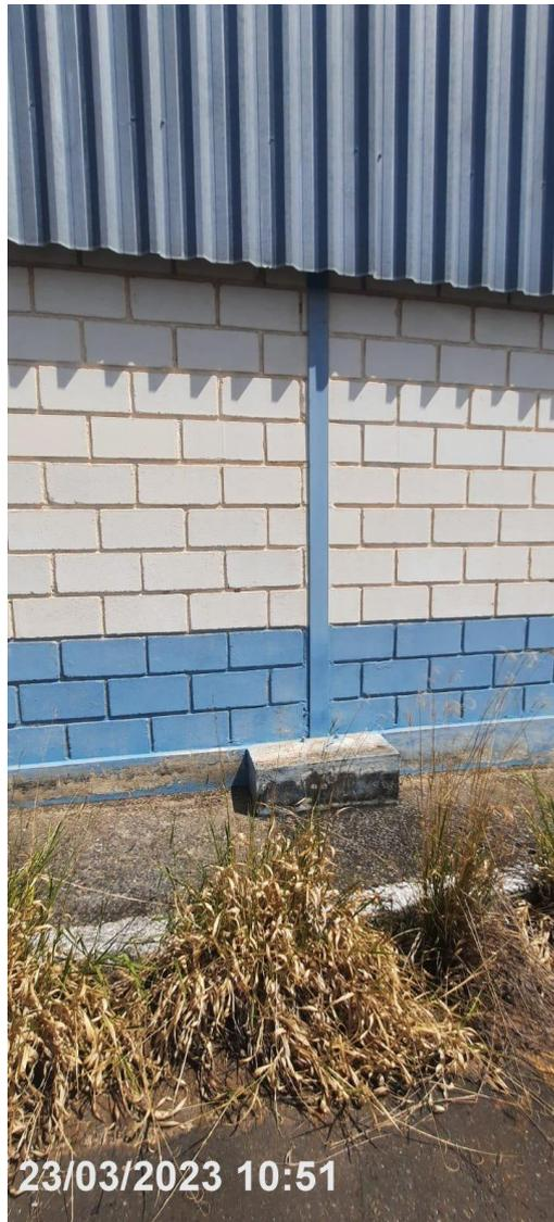
Detalhe da estrutura metálica e base do pilar
