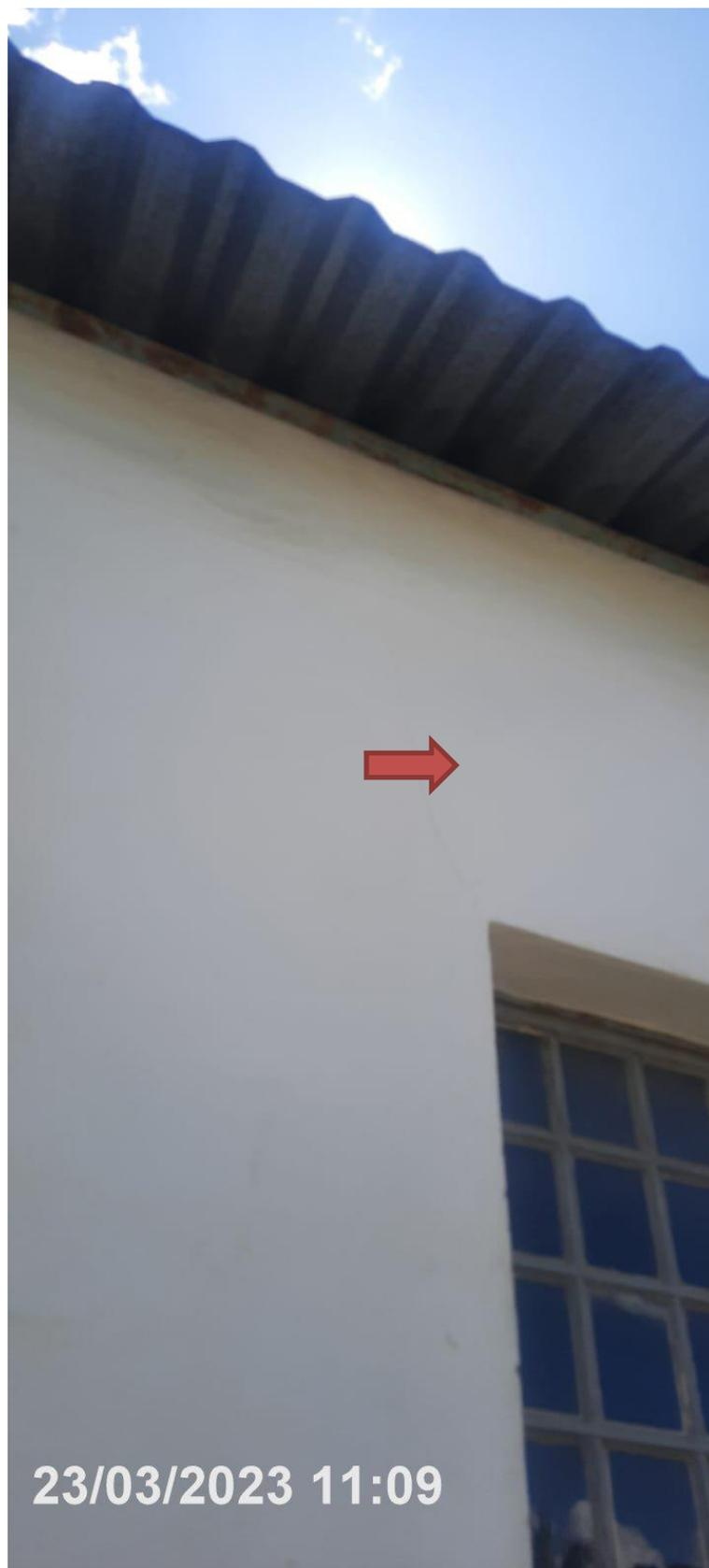
Trincas em alvenaria
