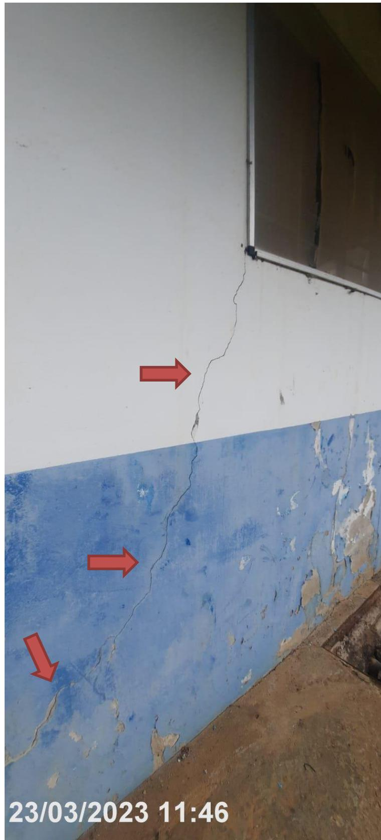
Trincas em paredes no Galpão 04
