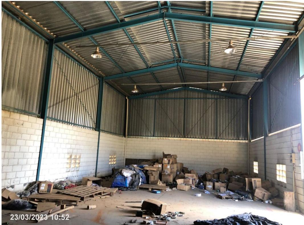
Detalhe do fechamento lateral, estrutura, luminárias e telhado do Galpão 01
