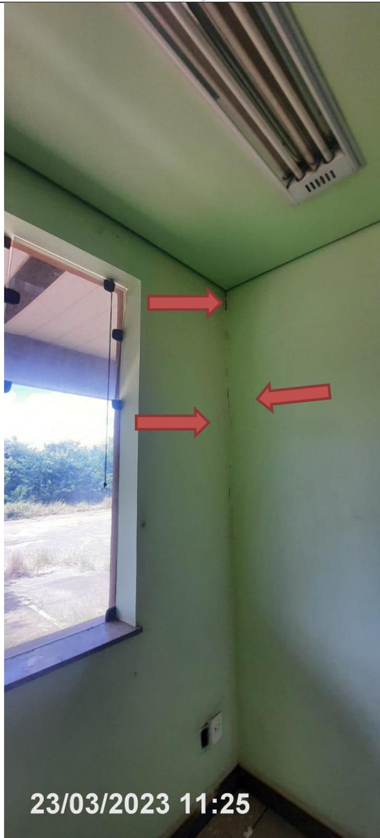
A trinca existente no corredor lateral aparece no mesmo lugar na recepção, porém não foi detectada na área externa
